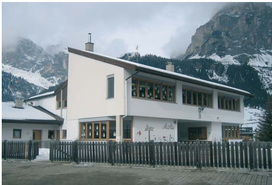
Sostituziun di vidri y dles portes tla scora elementara da Corvara
